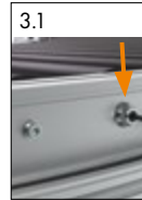
3.1 Sechskantmuttern lösen
